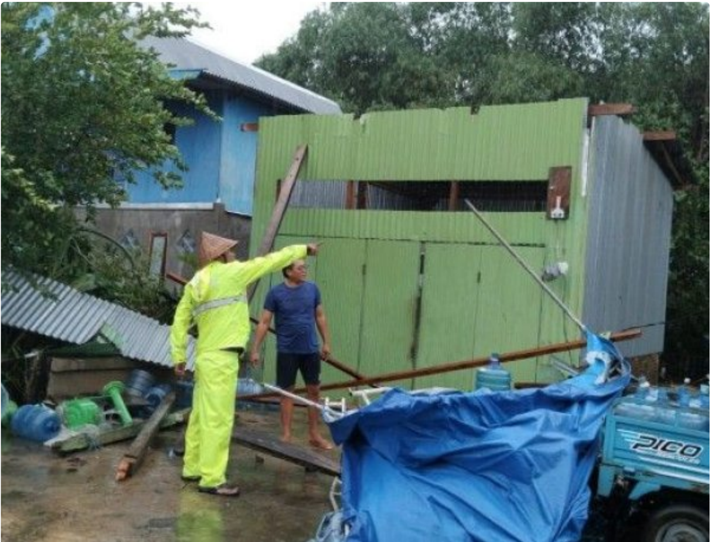
Cuaca Ekstrem, Puting Beliung Rusak Rumah Warga di Desa Kabba
